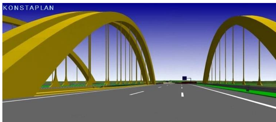
Stabbogenbrücke über den Dattel-Hamm-Kanal
